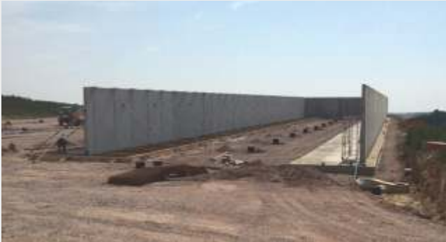
Siloplatte als Außenwand
